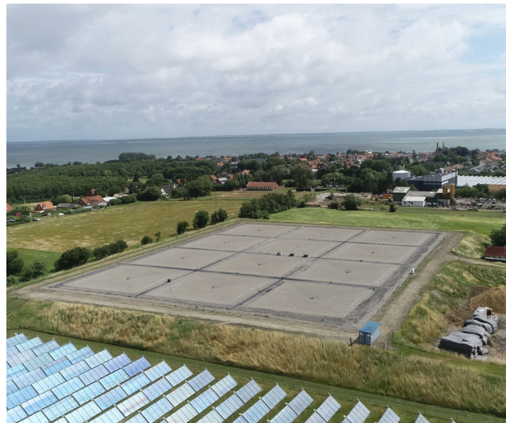
Overskudsvarme fra solvarme- eller biomasseanlæg og industrielle processer samt overskydende energi fra vindmøller og PV-paneler kan lagres i et damvarmelager for optimal energiudnyttelse og øget system-fleksibilitet
