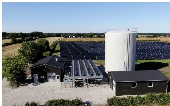
En varmepumpe kan med fordel integreres med andre energikilder; eksempelvis anvendes til effektivitetsoptimering af et solvarmeanlæg.
